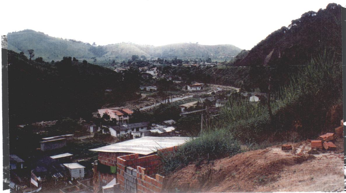
Fig. 4.38 - Visão parcial do vale do Rio Santo Antônio em fevereiro de 1995. Detalhe para o canal fluvial e as residências instaladas na planície aluvial (área sujeita a escorregamentos e a inundações).
