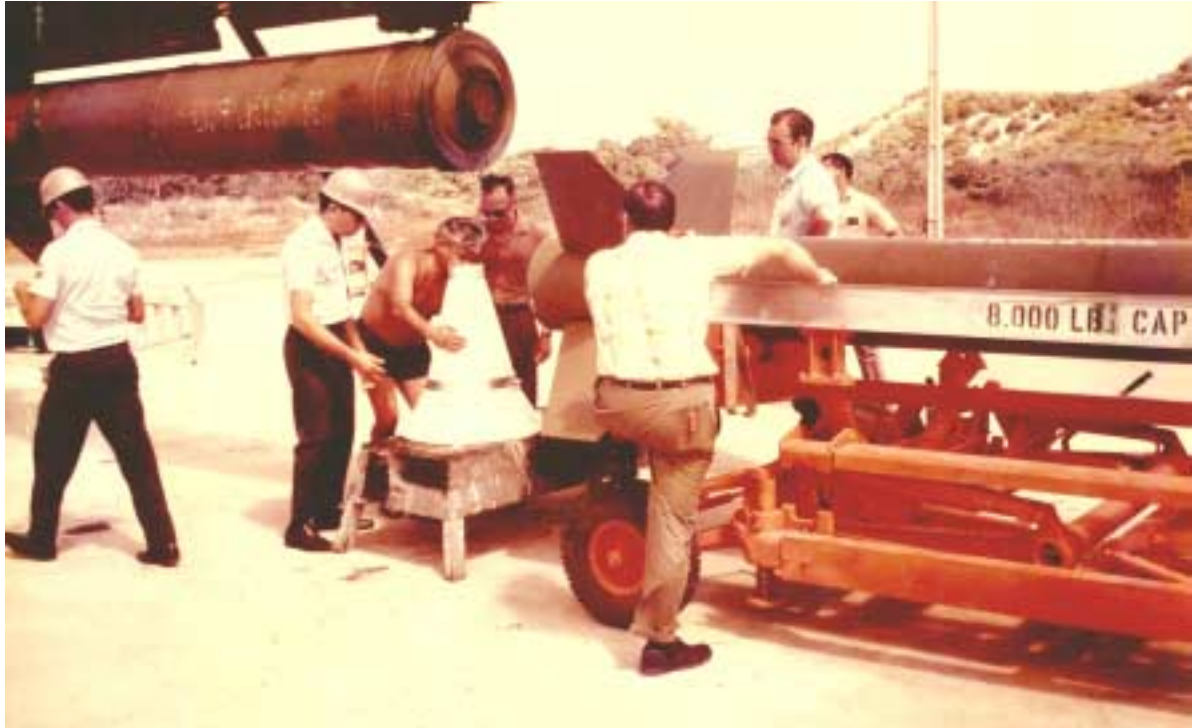
Figura 29 - Momento em que o JAVELIN era instalado no lançador, estágio após estágio. Vê-se o segundo estágio já no lançador e pronto para receber o acoplamento para o terceiro estágio. O autor aparece de capacete.
