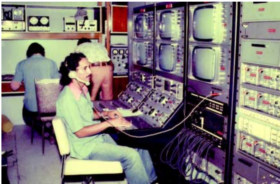
Figura 39 - O Centro de Controle da TV-U, após instalado.
