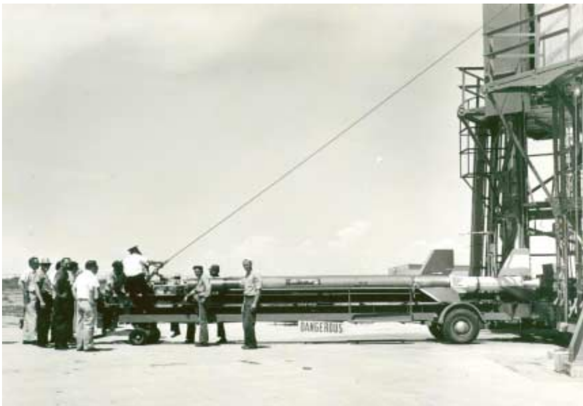
Figura 26 - Foguete AEROBEE todo montado no carrinho de transporte e pronto para ser verticalizado no lançador. Só na vertical, o foguete podia ser abastecido com o combustível líquido, com o oxidante líquido e pressurizado com gás hélio.
