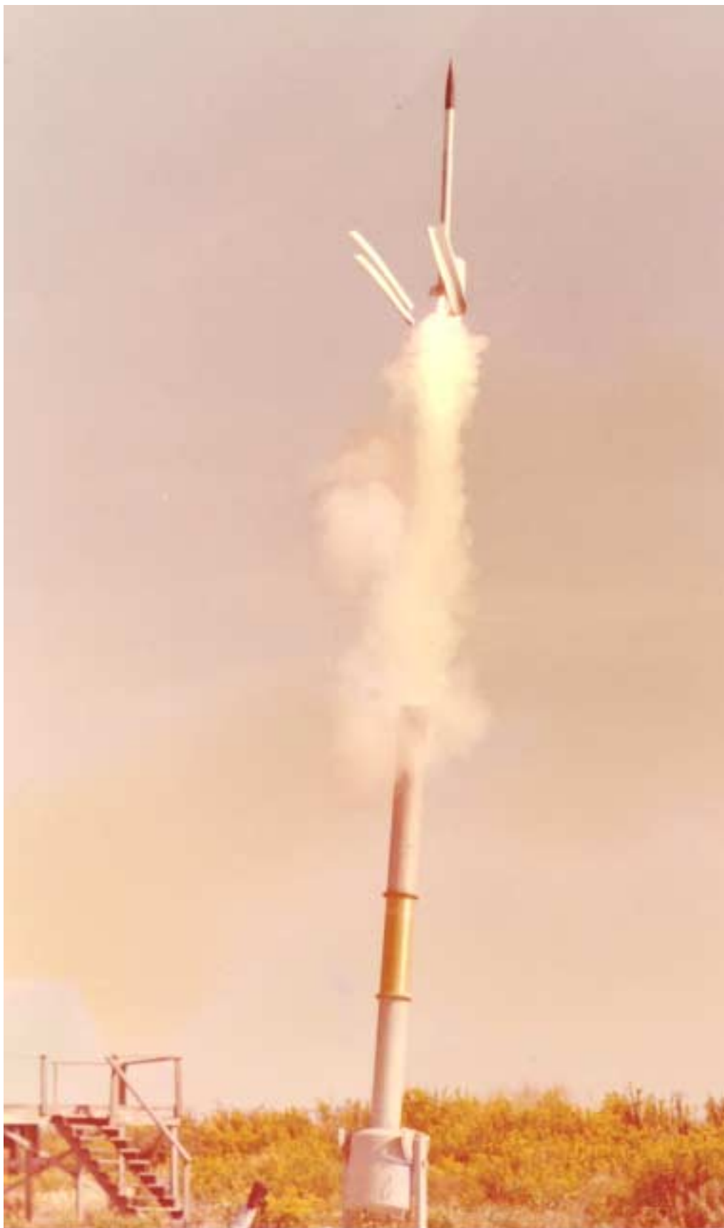
Figura 9 - Lançamento de um ARCAS, notando-se a ejeção do pistão de lançamento e as quatro peças de isopor. Foto de 1967.
