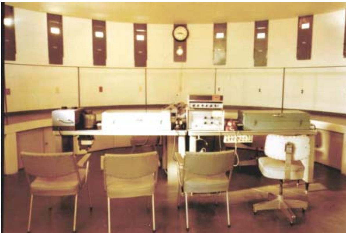
Figura 7 - Casamata, local de onde são procedidos todos os testes de carga-útil e verificação das condições do foguete, e efetuado o disparo. Foto de 1966.
