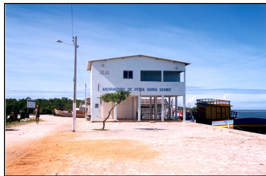
FIGURA 5.43 – Estruturas antrópicas abrigadas (ISA 8B), ancoradouro de pesca de Barra Grande em Icapuí.
