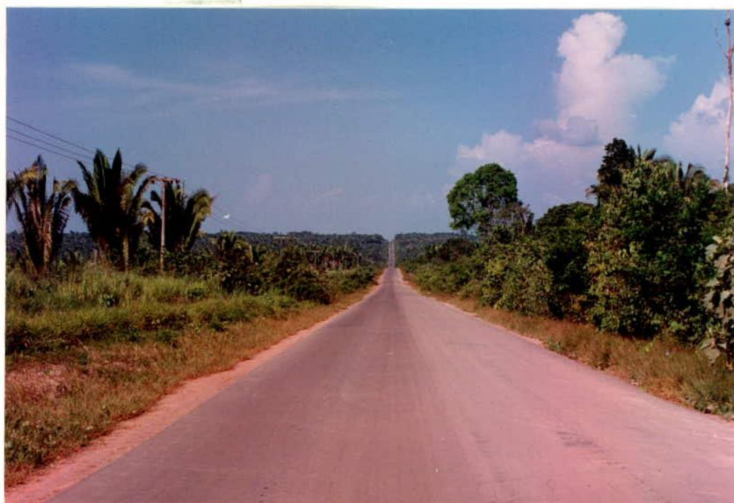
Fig. 3 - Presença muito expressiva de babaçu ( Orbignya speciosa ) localizado no Km 28,9 da rodovia Cuiabá-Santarém - 3 o ponto visitado.
