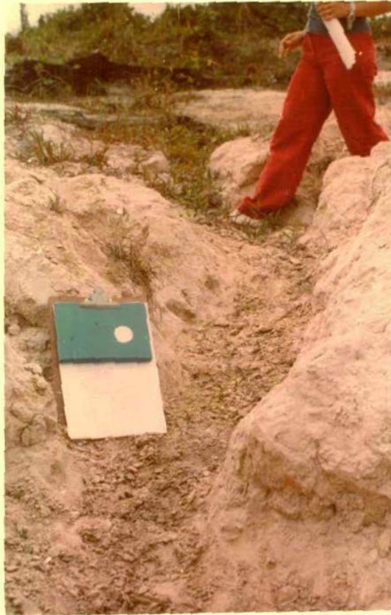
Fig. III.12 - Processo de erosão em sulcos.
