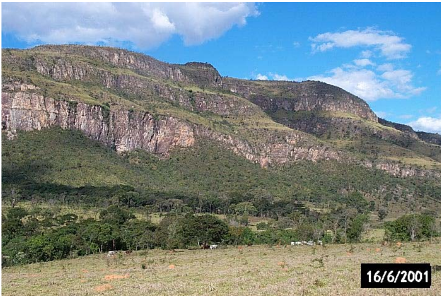
FIGURA 4.16 - Vista ao longo do vale do rio Turvo (Município de Capitólio – MG), em visada para oeste, mostrando os paredões com detalhes da movimentação dos blocos ocorrida no Terciário, dando origem a grabens (vale do rio) e horsts (paredões).
