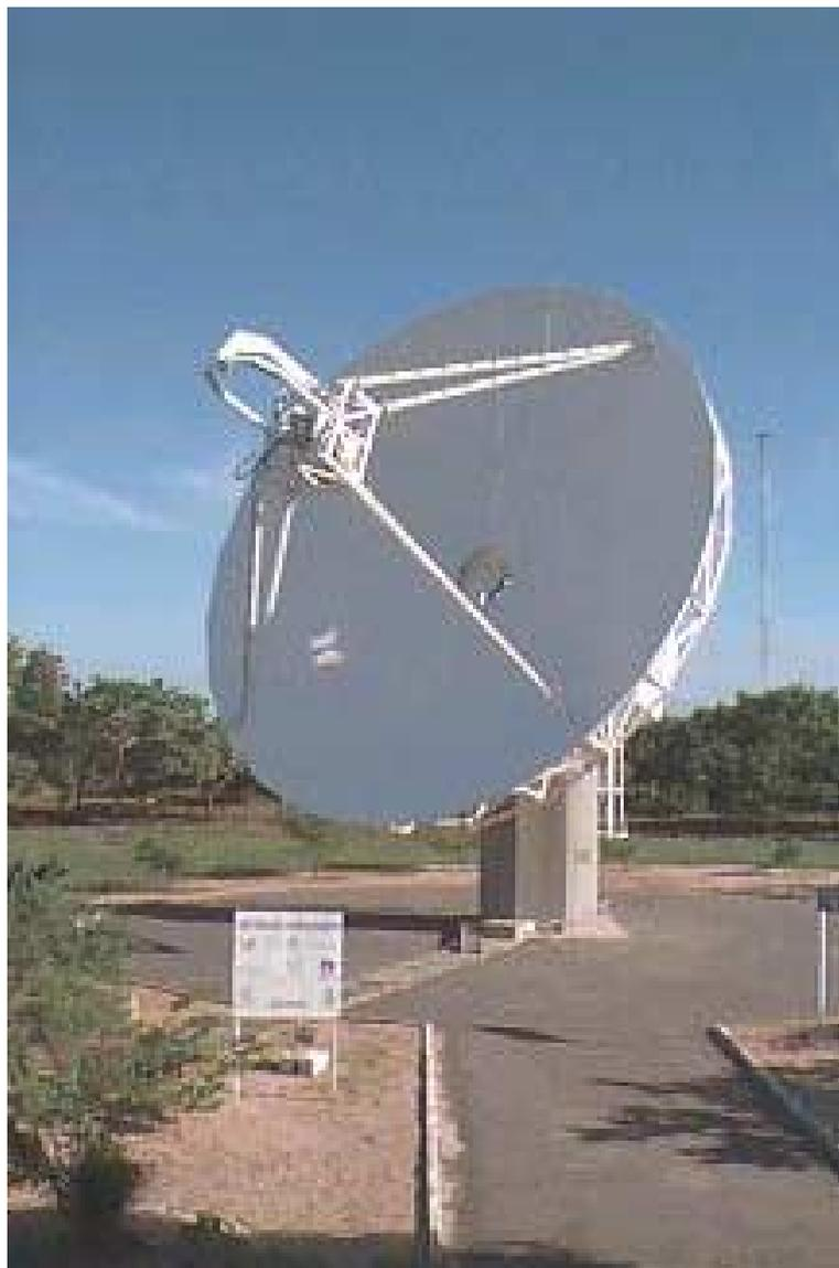
Figura 47 - Antena parabólica de 14,2 metros de diâmetro, que opera o VLBI.
