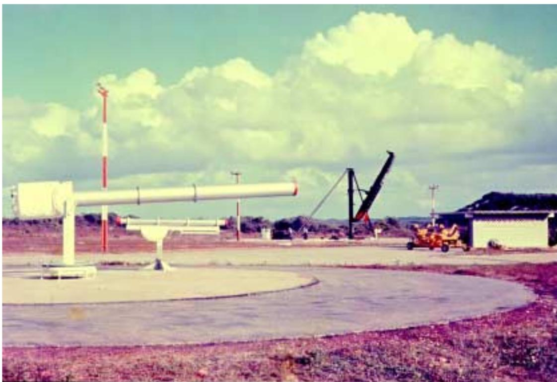
Figura 31 - Foguete BLACK BRANT-VC, no lançador, em condições de disparo. Nota-se, em primeiro plano os lançadores do ARCAS e do HASP.
