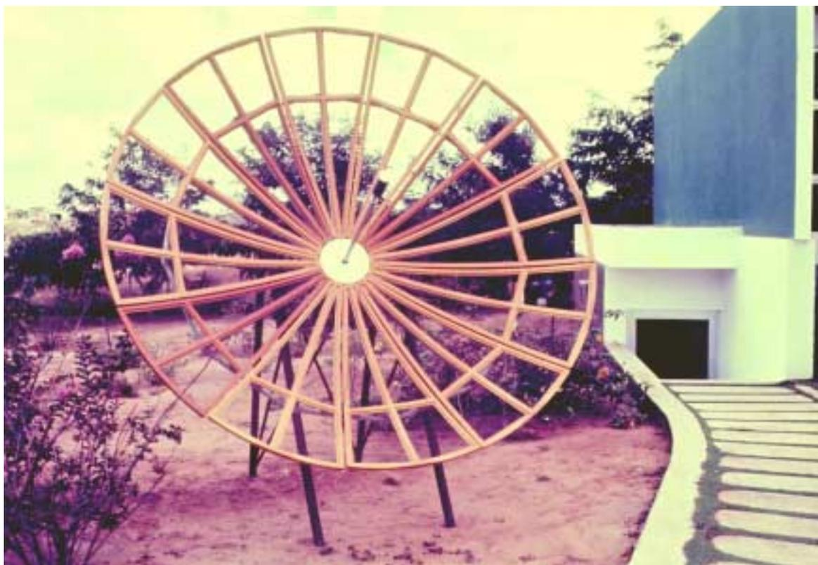
Figura 44 -Antena parabólica usada para recepção de imagens diretamente do satélite ATS-6, e que foram usadas pela primeira vez no Brasil, dentro do Projeto SACI.(EXERN). A foto é de 1973.
