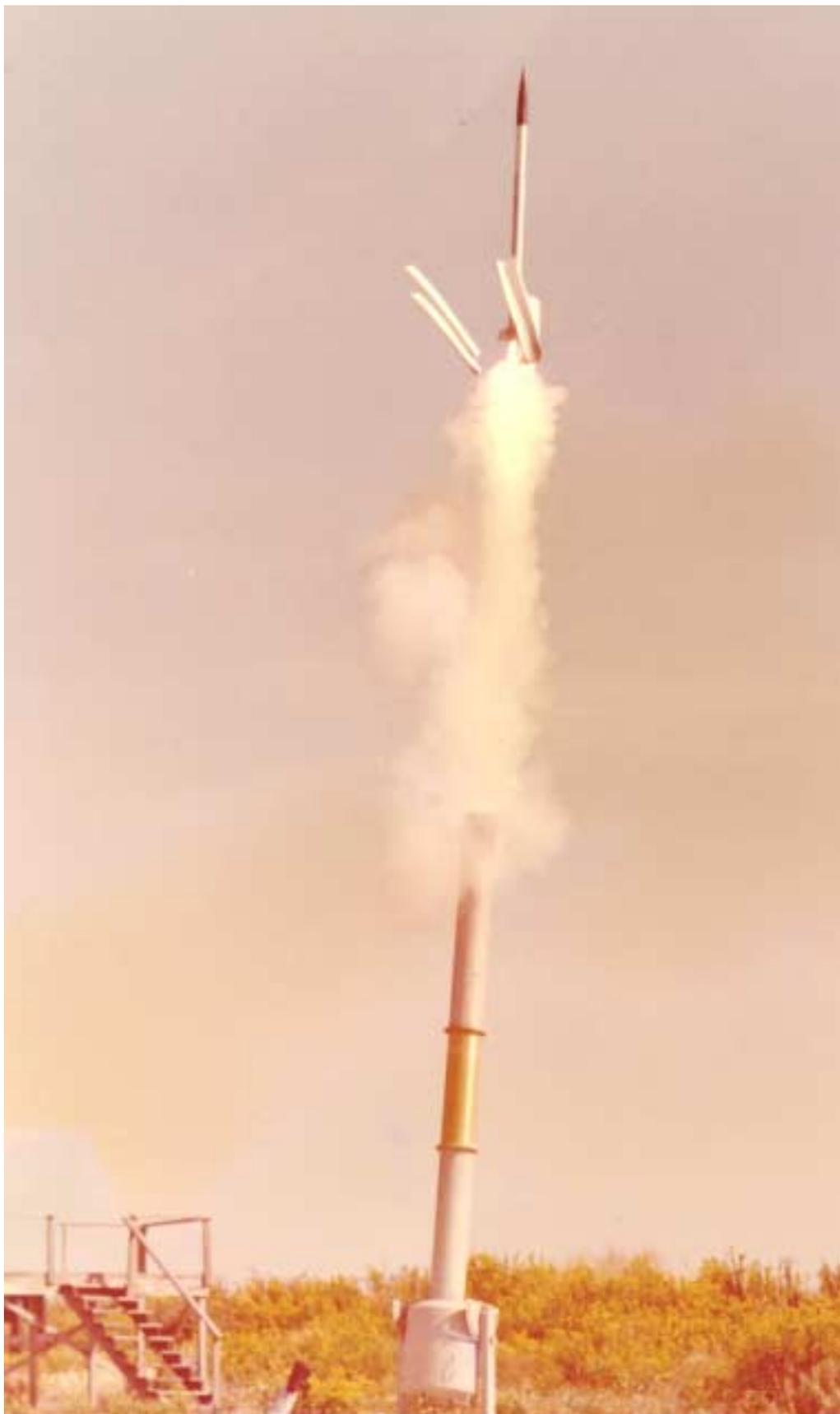
Figura 9 - Lançamento de um ARCAS, notando-se a ejeção do pistão de lançamento e as quatro peças de isopor. Foto de 1967.
