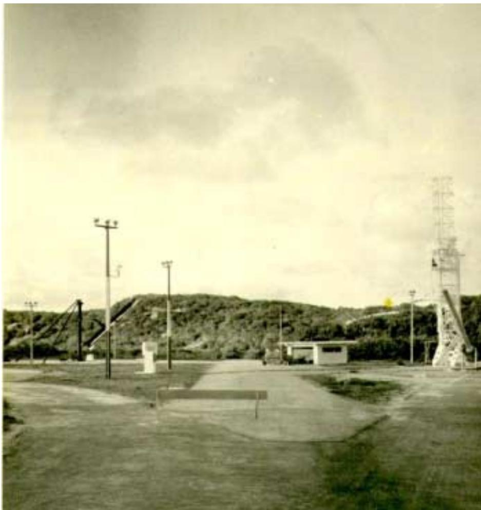
Figura 27 - O complexo de facilidades montadas no CLFBI para atender o lançamento dos foguetes AEROBEE, compreendendo a torre de lançamento, o depósito dos propelentes e meios de movimentação dos foguetes.
